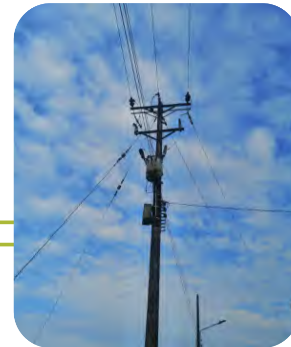
Ilustración 3. Estructura con cambio de conductor ACSR a ecológico.
