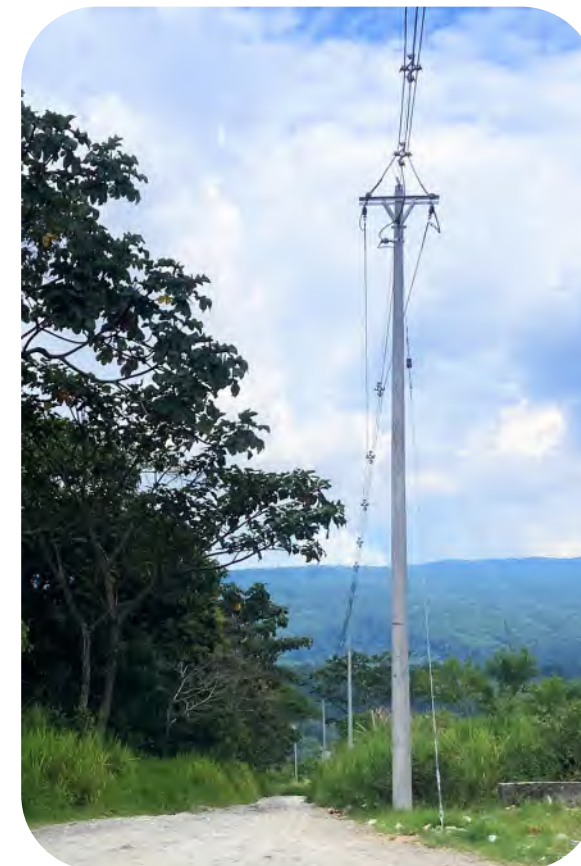
Ilustración 9. Construcción de Circuito - Red Compacta.
