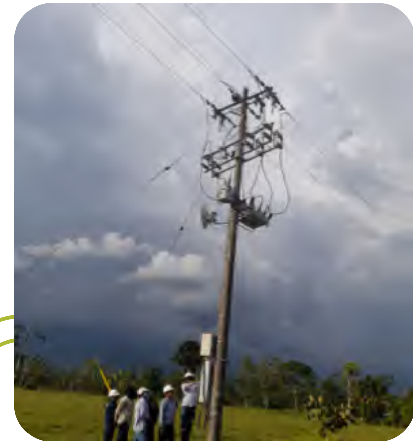
Ilustración 5. Ajuste y cambio por reconector nuevo.
