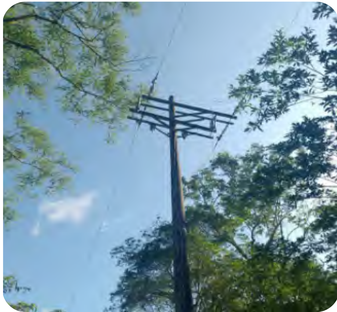
Ilustración 1. Estructura en poste con cortacircuitos convencional.
