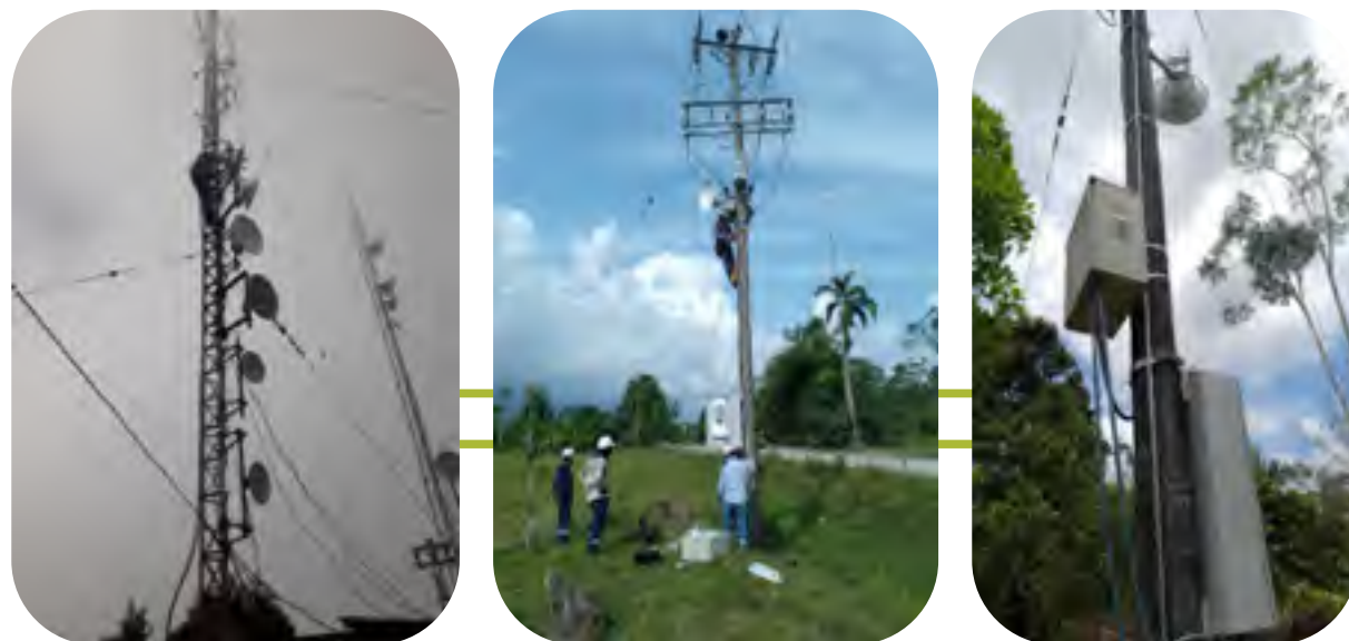
Ilustración 11. Montaje de equipos de comunicaciones.
